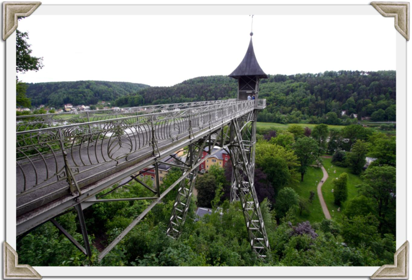
Der frei stehende 50 m hohe Stahlfachwerkturm wurde komplett im Jugendstil gestaltet. Oben verbindet eine Brücke den Turm mit einem Waldweg auf der Hochebene. Hier befindet sich auch ein Freigehege, welches Luchse beherbergt.
